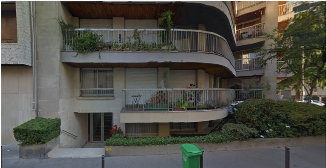
Rue du Commandeur, Paris
